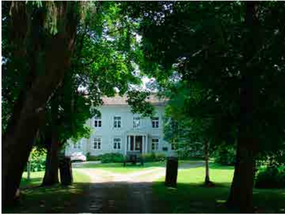
Selkis översteboställe idag. Det ursprungliga huset hade brunnit ner till grunden år 1758, och det skulle dröja till 1786 innan det nya överstebostället blev färdigt. Makarna de Carnall var intill Carl Constatins frånfalle 1773 hänvisade till tillfälliga bostäder i Selkis.
