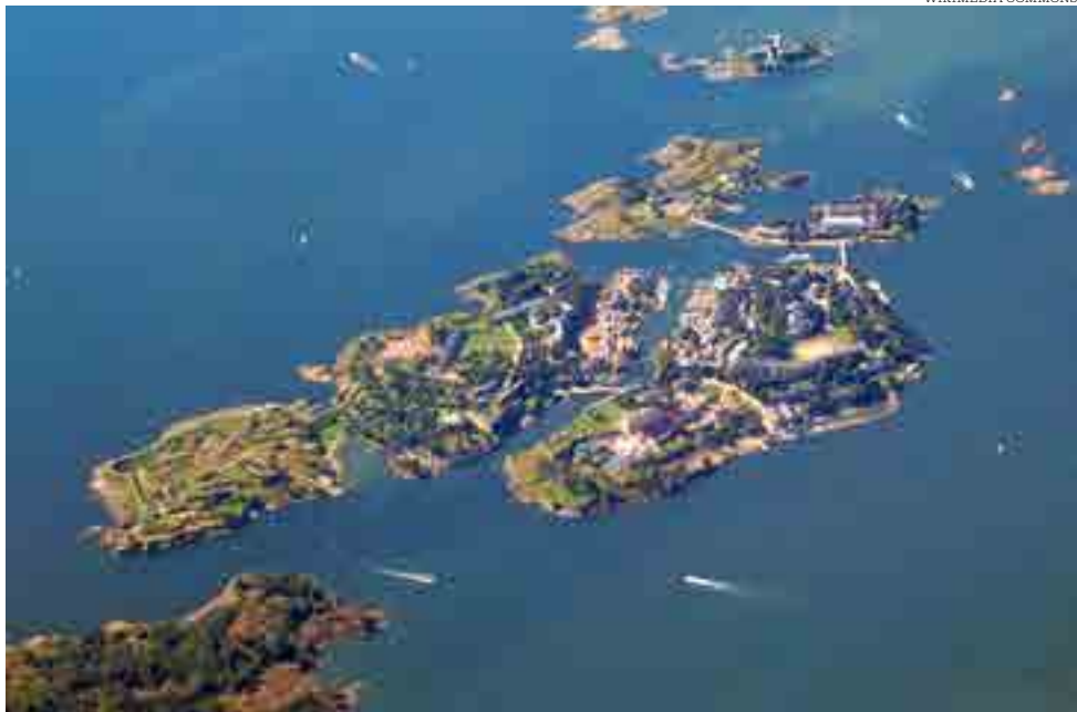
År 1748 inleddes befästningsarbetena på Wargöskär utanför Helsingfors. Två år senare döps fästningen till Sveaborg.
