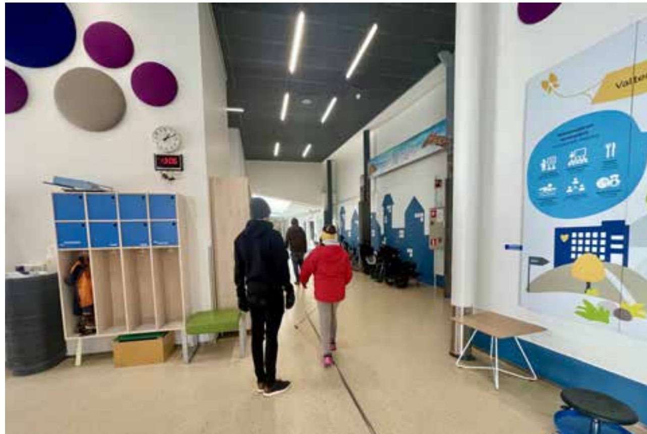
En metallskena i golvet hjälper elever med synnedättning att orientera sig. Korridorerna är breda och möbler och hjälpmedel är placerade längs väggarna så att de inte är i vägen.
