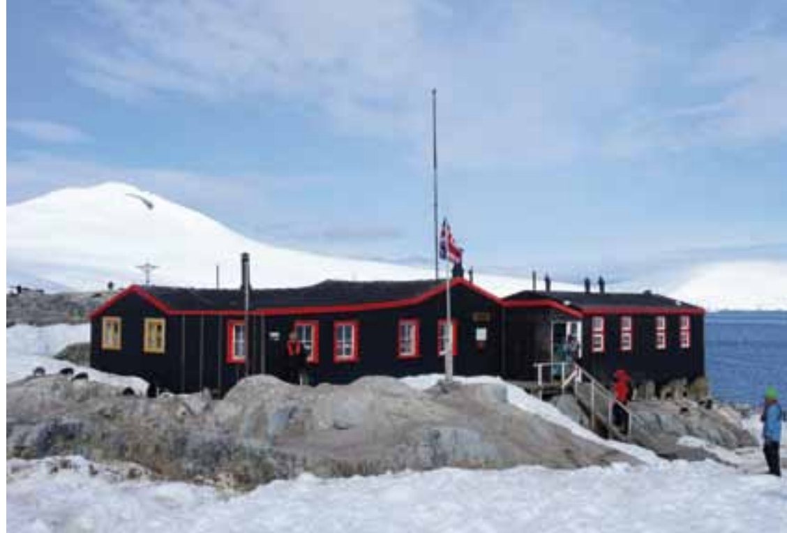
Den restaurerade forskningsstationen i Port Lockroy.
